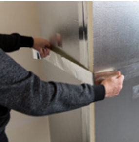
4 Calfeutrer pour isoler à l'eau et à l'air
