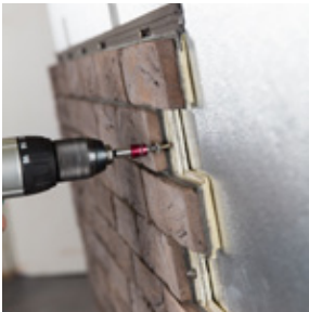
7 Visser et ajuster + ou - pour faciliter l'emboîtement des autres plaques
