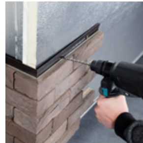
5 Percer et fixer l'angle de départ
