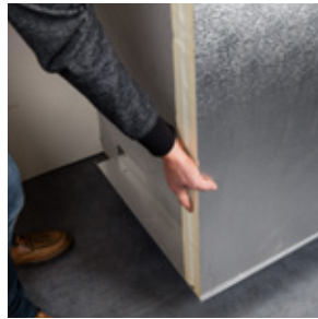
2 Poser l'isolant dans le profil
