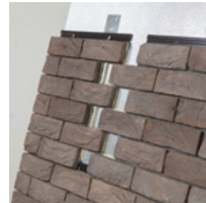
9 Emboîter à nouveau sur le côté tous les panneaux
