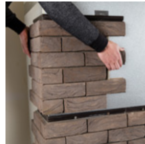
8 Emboîter l'angle au dessus
